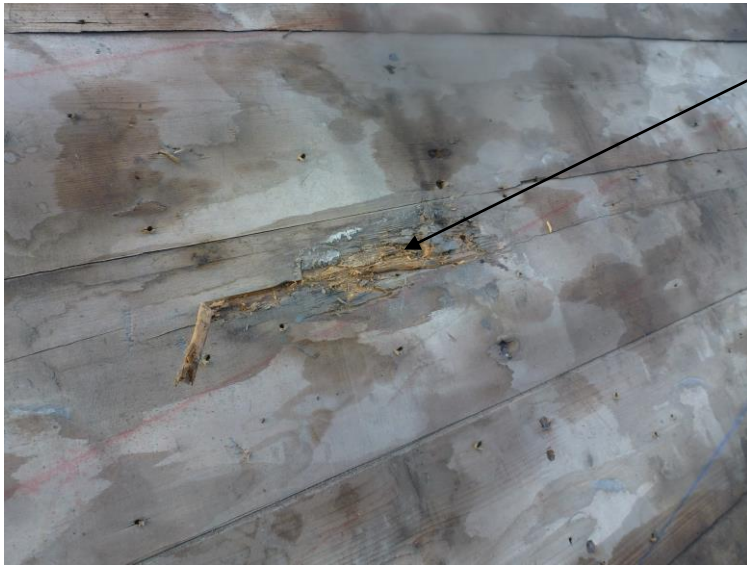
Beginnende aantasting van dakhout i.v.m. de matige overlap van de leien.
