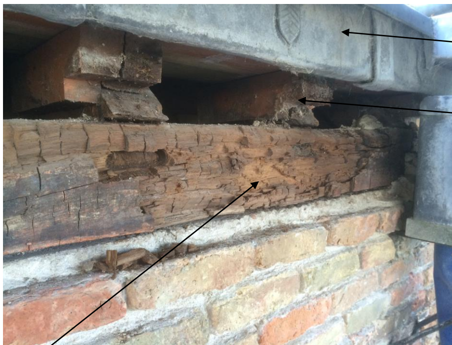
Aangetaste onderslagbalk
